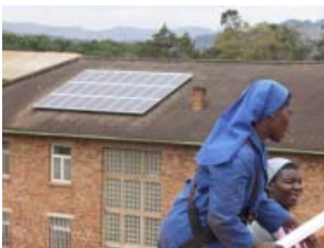
Die Solaranlage auf dem Dach ergänzt die Stromversorgung
