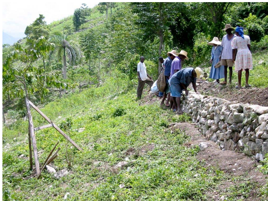
Bau einer Erosionsschutzhecke
